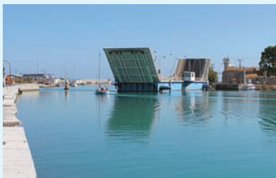
Le pont flottant qui relie Lefkada à Akarnania
