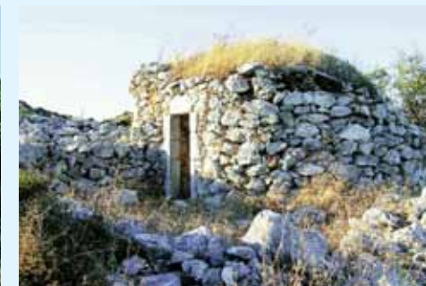
Stavení zvaná „Volti“ v Ag. Donatos
